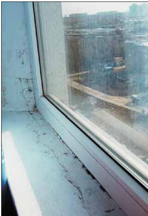
Плесень на подоконнике с плохо установленным стеклопакетом.
